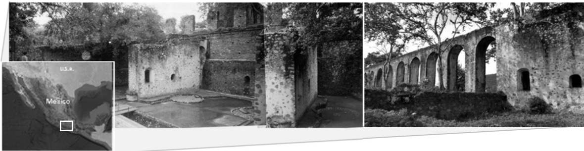
Figura 1.- Sistema hidráulico en la Hacienda de San Juan Bautista: acueducto, canales y patio de molienda.
