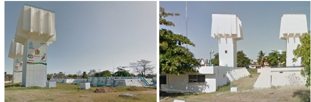
Figura 3. Izquierda: Tanques elevados; Derecha: Tanque superficial #1 y #2
